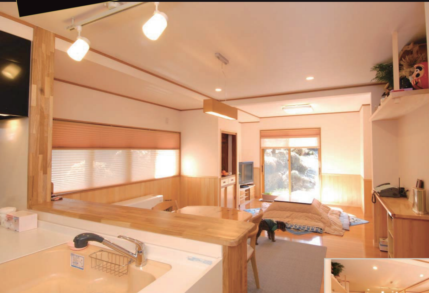
約18畳のリビングキッチン。節なしの木曽ヒノキの腰板を使用、窓下には蓄熱式暖房機を設置しました。
